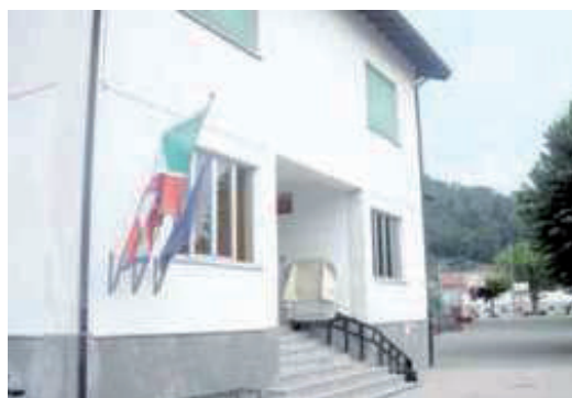
Il porticato delle scuole modificato
