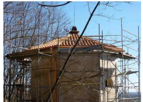
la sistemazione del manto di copertura e le nuove opere di lattoneria in rame
