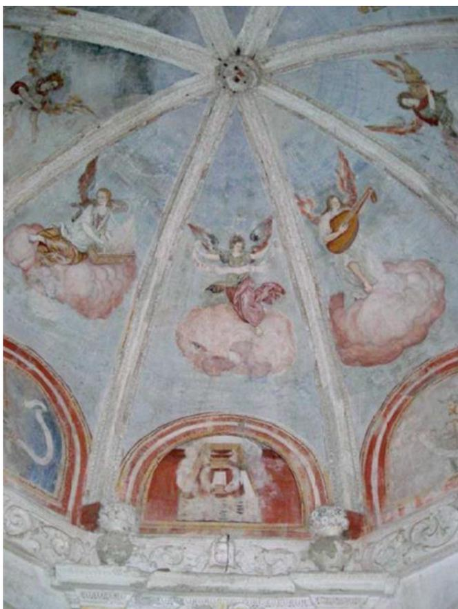
Le lacune ampie e profonde sulla fascia di imposta della volta sono state riempite con calce e sabbia a diversa granulometria e le cavità create dai distacchi sono state colmate con iniezioni di maltine in
